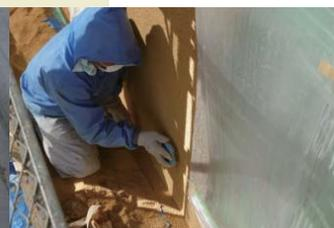
表面をブラシで掻き落とす、「人造石掻き落とし仕上げ」の作業
